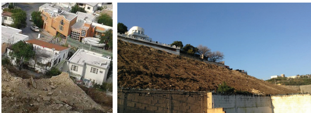
Figura 4. Predio mostrando los trabajos de terracería y desmante.
