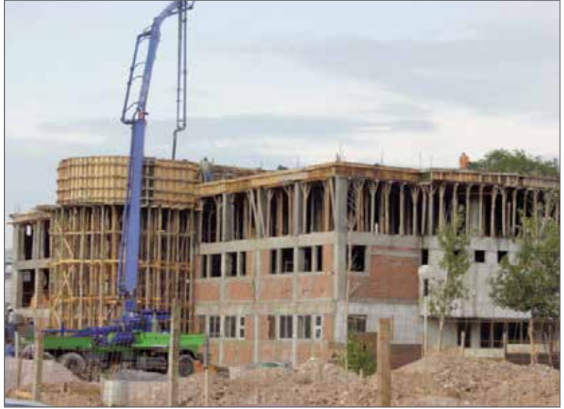
Figura 1. Construcción del edificio A de la CCSYH. Fue hasta 2003 en que inició la construcción del primer edificio que albergaría a las tres licenciatura
