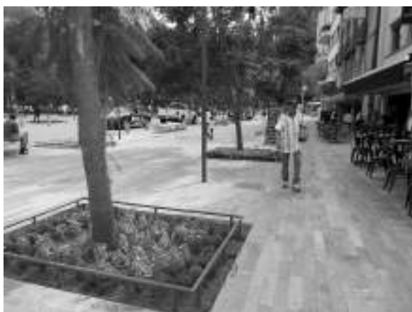
Jardinera con bordillo de protección.
