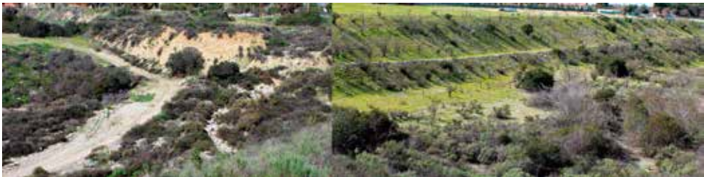
Figura 9.7. Cuando las condiciones topográficas son una barrera para la restauración es necesario modificarlas, una de las medidas más frecuentes es modificar la pendiente para estabilizar el sustrato y facilitar el desarrollo de la vegetación.
