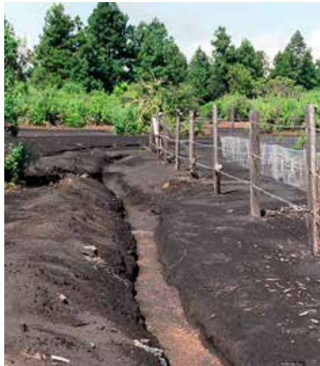
Figura 10.8. Sustrato inestable en un sitio de restauración, para reducir el transporte de la arena se cavaron zanjas siguiendo las curvas de nivel.
