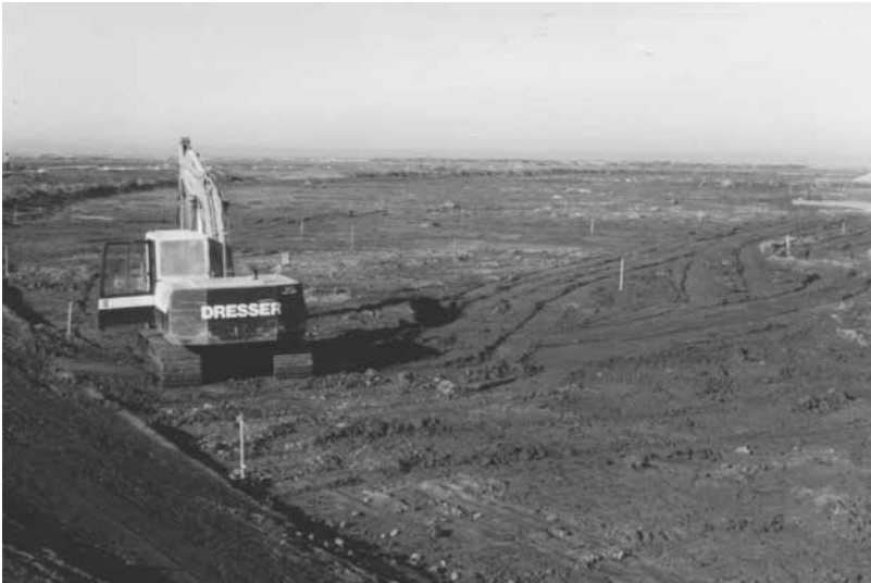
Figura 9.13. Trabajo en el estuario del Río Tijuana para crear condiciones que permiten alterar la microtopografía para favorecer el establecimiento de la vegetación de la marisma.
