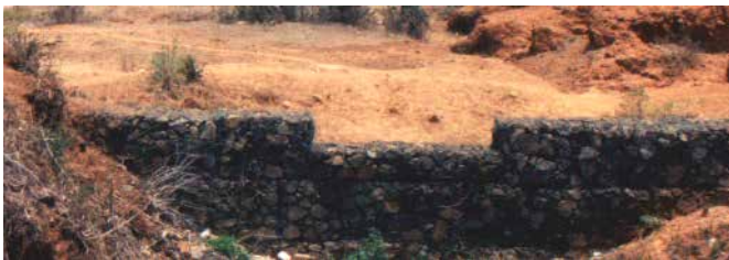
Figura 9.8. Presa de gaviones para controlar la escorrentía.
