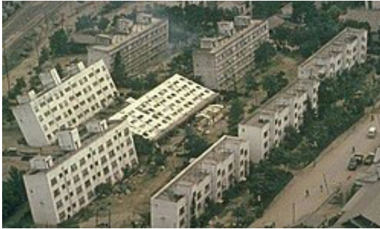
Foto 1. Volcamiento de edificios en Niigata (Japón) 1964 [17]
