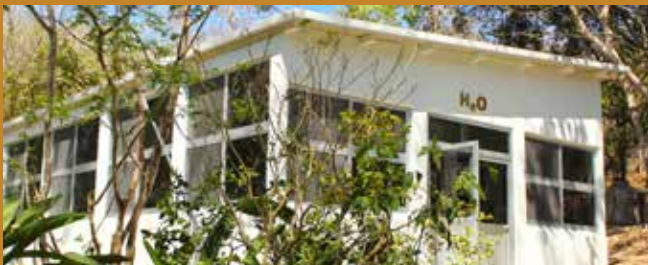
Vista parcial de H2O (Planta Purificadora de agua). UMAR, Campus Huatulco
