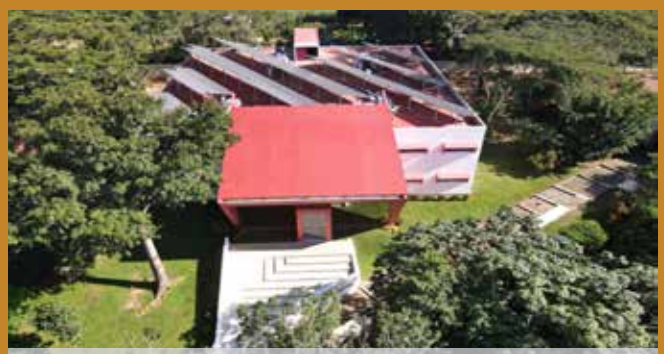
Parque Solar 2. UNPA. Campus Tuxtepec.
