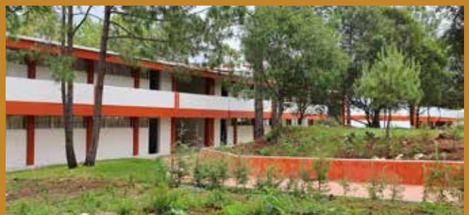
Edificio de aulas y anexos. UNICHA. Chalcatongo de Hidalgo
