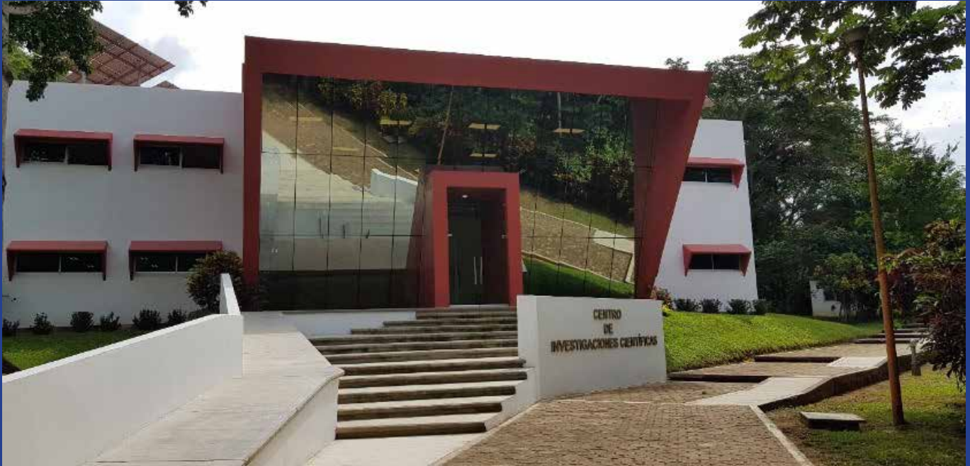
Centro de Investigaciones Científicas. UNPA. Campus Tuxtepec.
