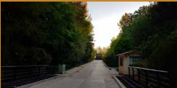
Pavimentación con concreto hidráulico a partir del acceso principal al helipuerto. UTM. Huajuapán de León
