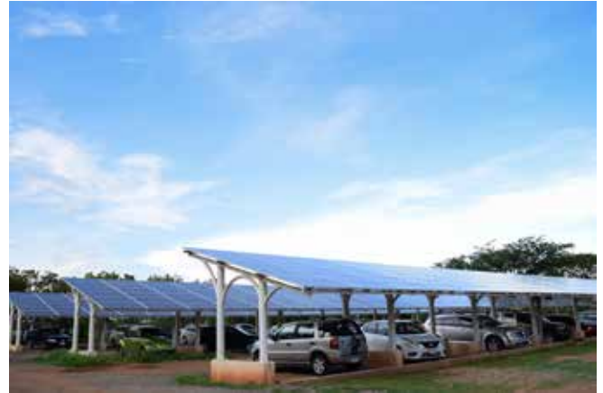
Parque solar fotovoltaico. Campus Tehuantepec
