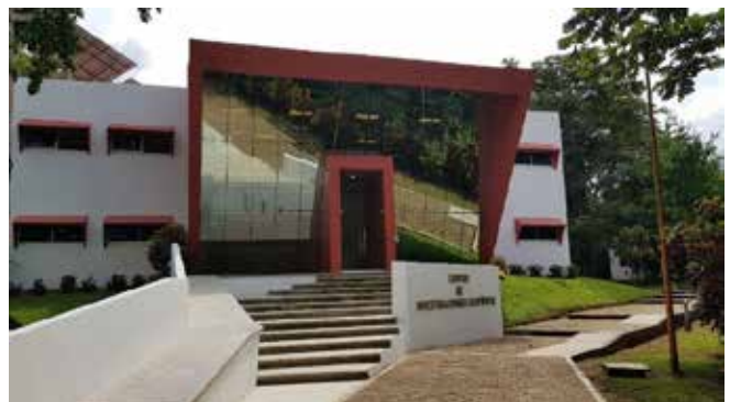
Centro de Investigaciones Científicas, (UNPA-Campus Tuxtepec)
