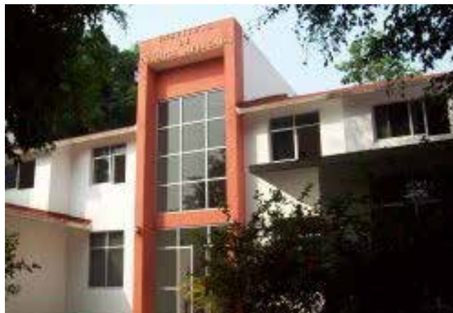
Instituto de Química Aplicada (UNPA-Campus Tuxtepec)
