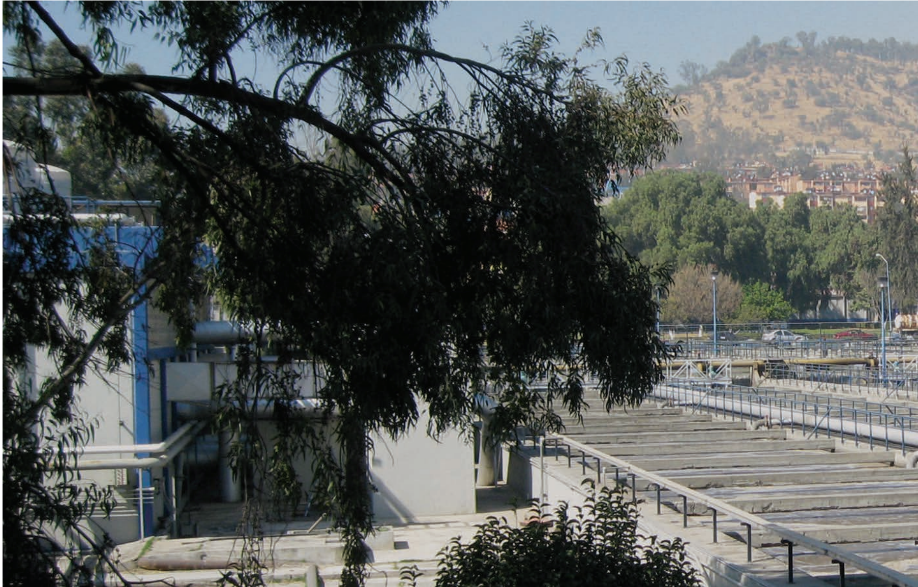
Planta de Tratamiento de Aguas Residuales, Cerro de la Estrella, Iztapalapa.
