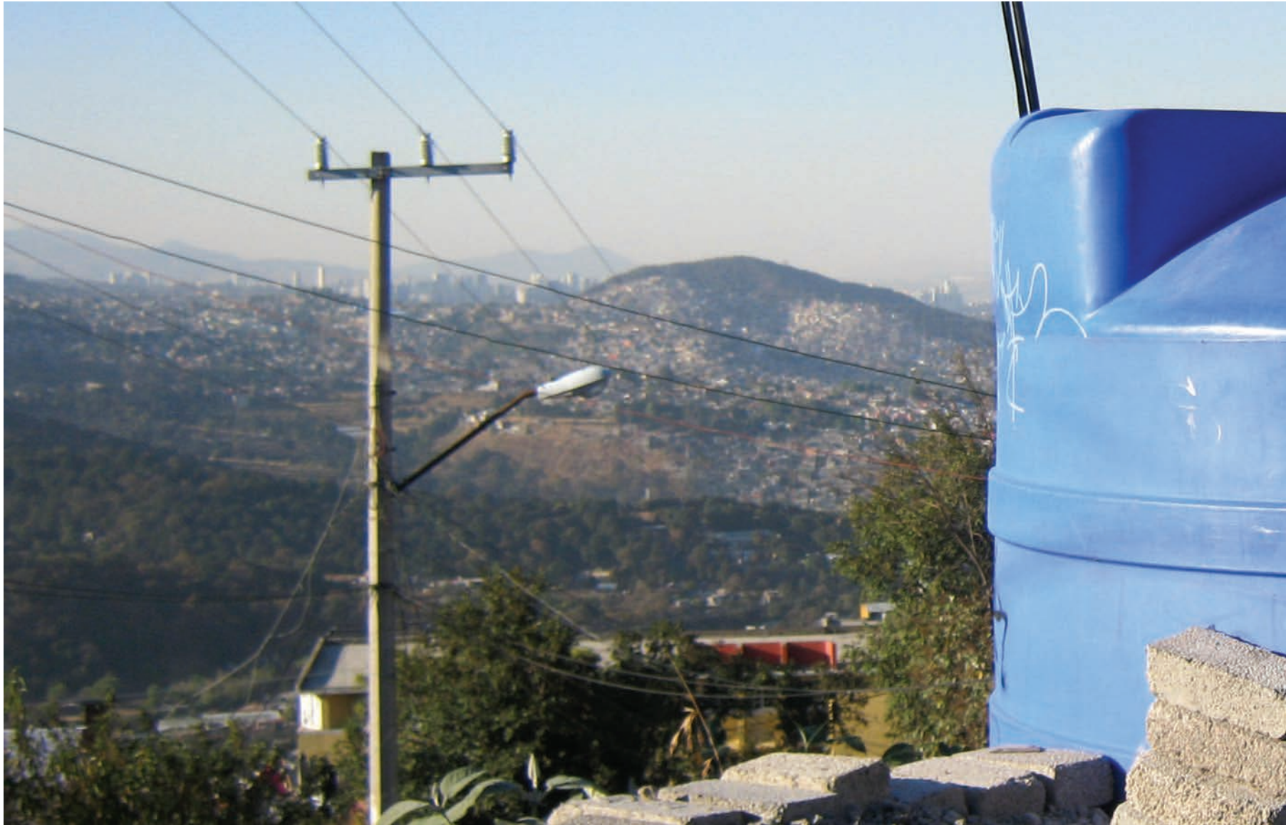
Bidón (contenedor de agua) en la altura, San Nicolás II, Tlalpan, D.F.
