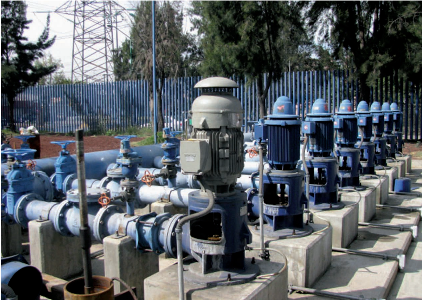
Acueducto de Santa Catarina, Iztapalapa.
