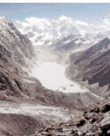
El lago glacial de Tsho Rolpa se está agrandando como consecuencia del derretimiento del glaciar y la frágil represa formada por la morena corre riesgo de colapsar. El riesgo de aluviones de ruptura se redujo en un 20% reduciendo el nivel de agua artificialmente 3 metros en 2002.
