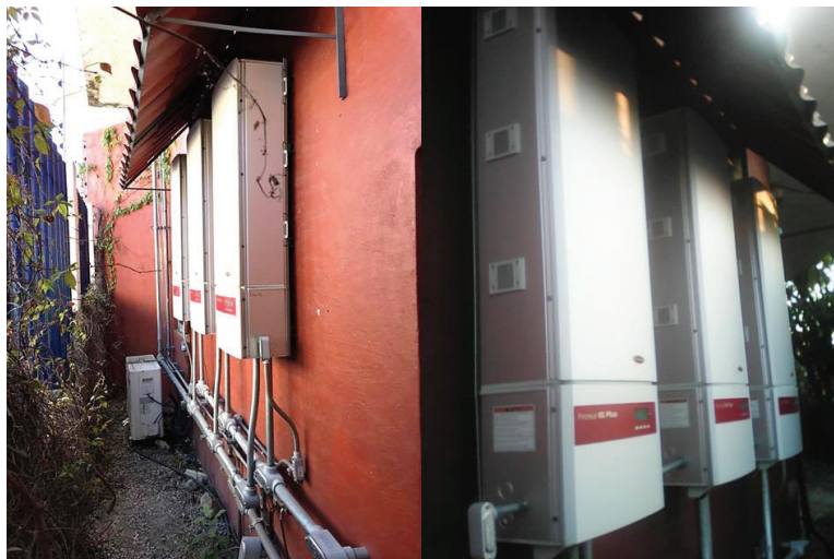
Figura 7.10: Inversores IG Plus V 10.0-3 Delta de la PSFV-27
