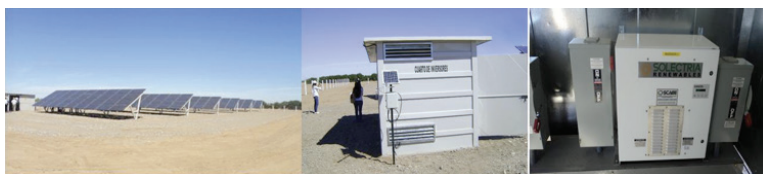
Figura 1.2: SFV-I de 45.0 kW para una procesadora de cárnicos
