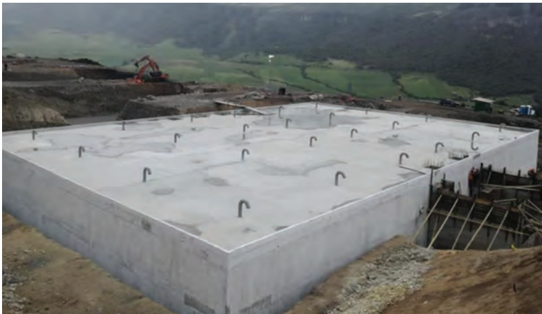
Figura 27 Planta de tratamiento, avances febrero 2019
