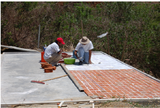
Figura 6-XVI Instalación del soporte y catalizador.
