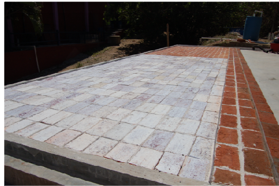
Figura 6-XVII Vista del reactor terminado.
