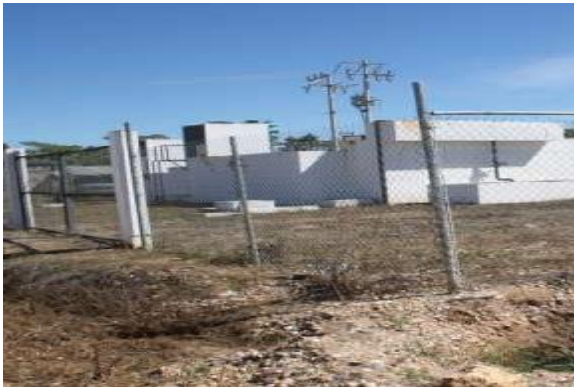
Foto 8. Planta de Tratamiento de Aguas Residuales de Tehuantepec. Fuente: Captura propia. Julio, 2012
